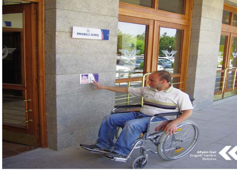
Şekil 14. Afyon Garı Engelli Yardım Butonu Kaynak:(T.C. Ulaştırma ve Altyapı Bakanlığı, 2019)
