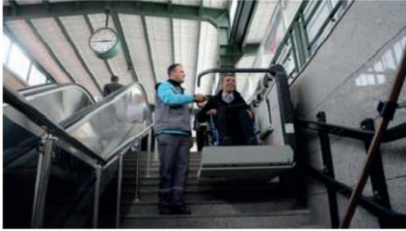
Şekil 8. Ankara Garı Asansör Merdiven Kaynak:(T.C. Ulaştırma ve Altyapı Bakanlığı, 2019)
