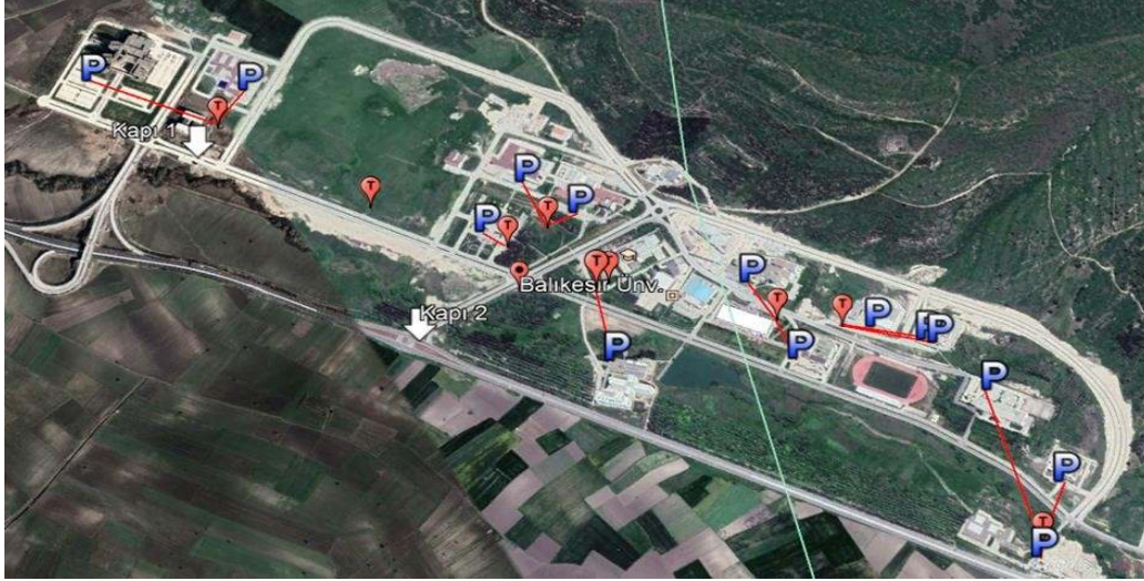
Şekil 3. Kampüs otopark ve trafo merkezlerinin genel görünümü
