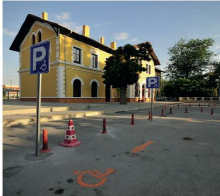
Şekil 15. Konya Garı Engelli Otoparkı Kaynak:(T.C. Ulaştırma ve Altyapı Bakanlığı, 2019)
