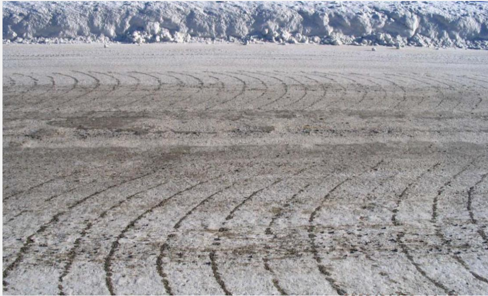
Şekil 6: Sıcak Islatılmış Kumlama Yöntemi Uygulandıktan Sonra Kaplamanın Görünümü
