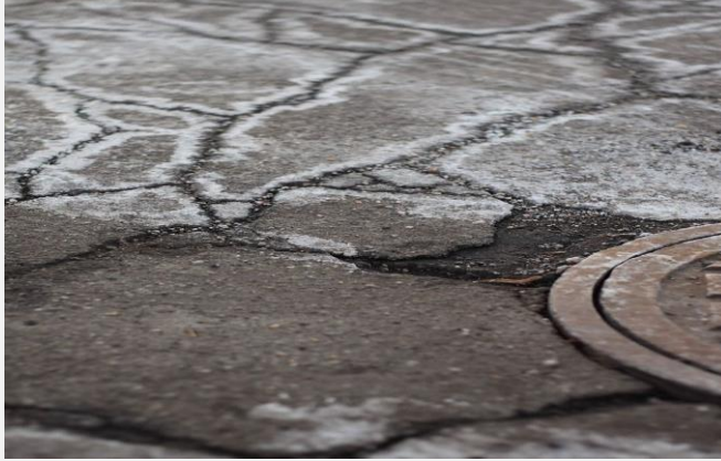
Şekil 5: Tuzlamanın Kaplamalara Etkisi
