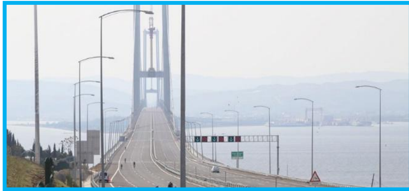
Şekil 2-36: Osmangazi köprüsü SCADA ve otomasyon sistemi
