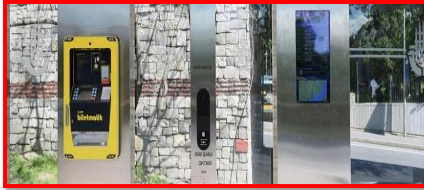
Şekil 2-37: Konsept akıllı durak uygulaması
